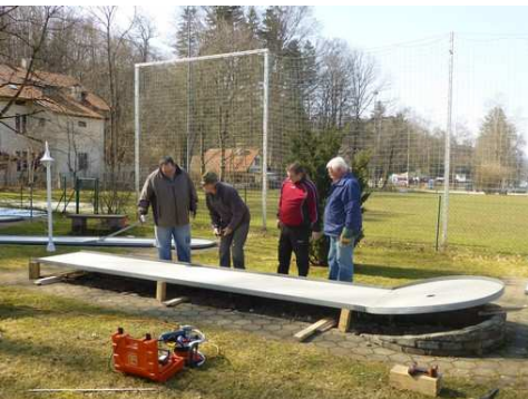
An etlichen Bahnen wurden die alten Platten ausgetauscht
