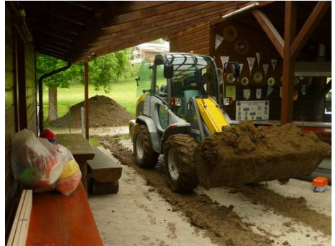
Der Humus wird abtransportiert
