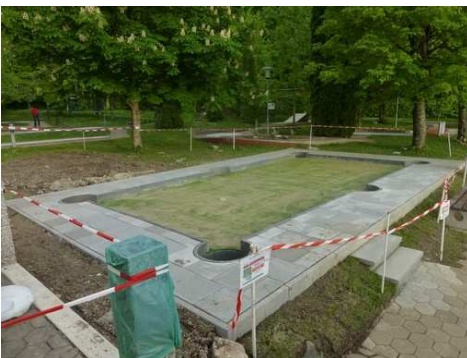
Das Pflaster ist verlegt
