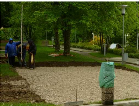
Die Kiesschicht wurde eingebracht
