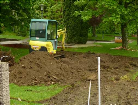
Der Humus wird abgegraben
