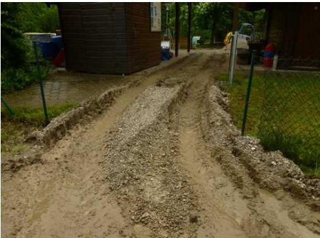
Dieser Schaden muß wieder bereinigt werden
